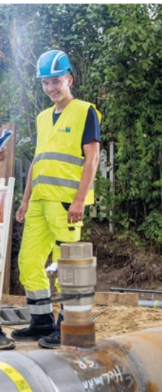
Auch Guido Laader (Mitte) von den Gelsenwasser Energienetzen musste mit seinem Team schon an Heiligabend ausrücken.
